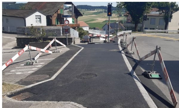
Rehaussement et déplacement du passage pour piétons sur la Route du Poyet et trottoir traversant au sommet du chemin.
