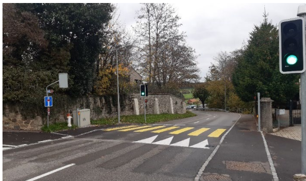
Rehaussement et déplacement du passage pour piétons sur la Route du Poyet et trottoir traversant au sommet du chemin.
