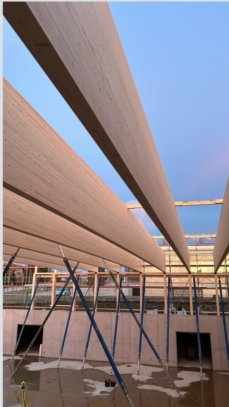
Porteurs charpente salles de sport
