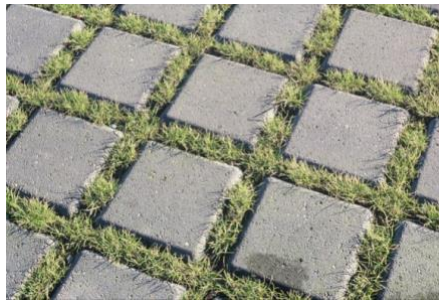
Fig. 6 : Exemple de pavés-gazon – Source . struykverwoinfra
